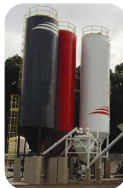
Silos de Cimento
